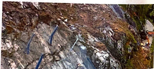
Durch die umfangreichen Arbeiten an der Oppenberger Straße sind bis jetzt Kosten von rund 430.000 Euro angefallen. Foto: Steid/Huber
